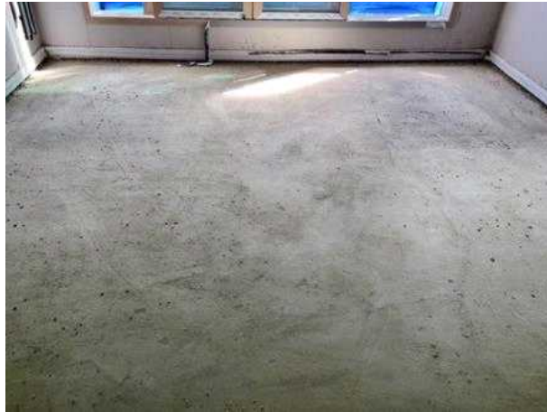
(a) 측면완충재 시공
