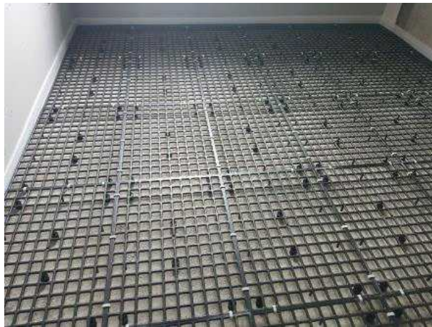
(b) 슝리스 방진프레임 시공
