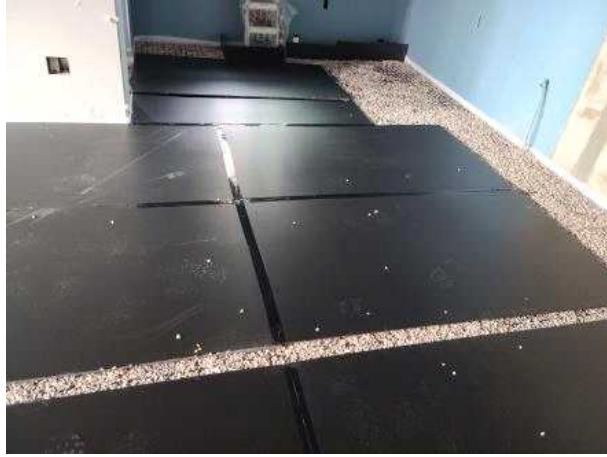
(d) PP보드 시공
