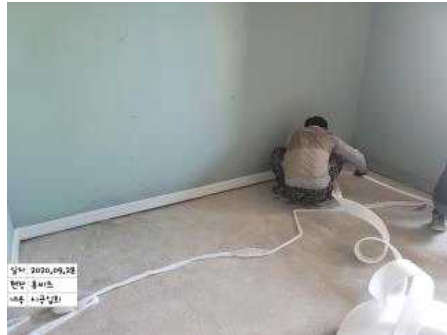
(a) 측면완충재 시공
