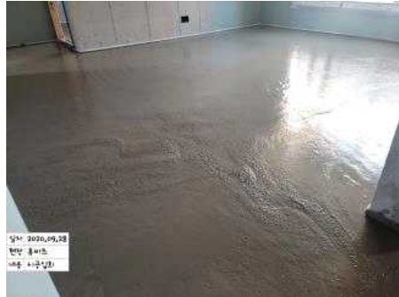
(c) 경량기포콘크리트 타설
