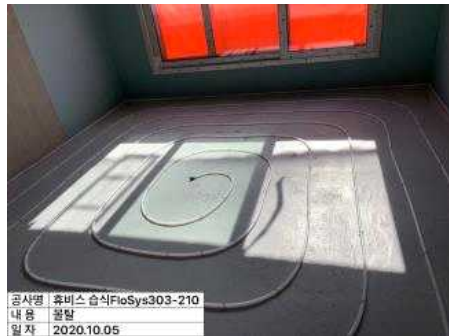
(d) 난방배관 시공
