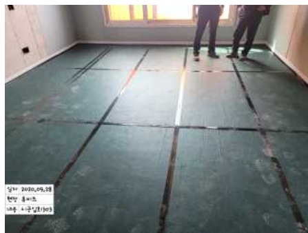
(b) HVS30C 완충재 시공
