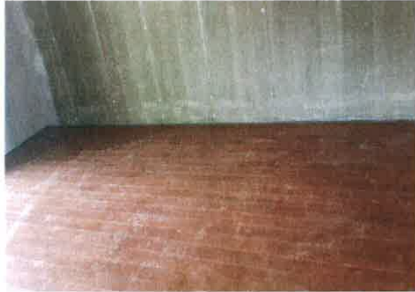
(h)치장목질마루판 시공 후
