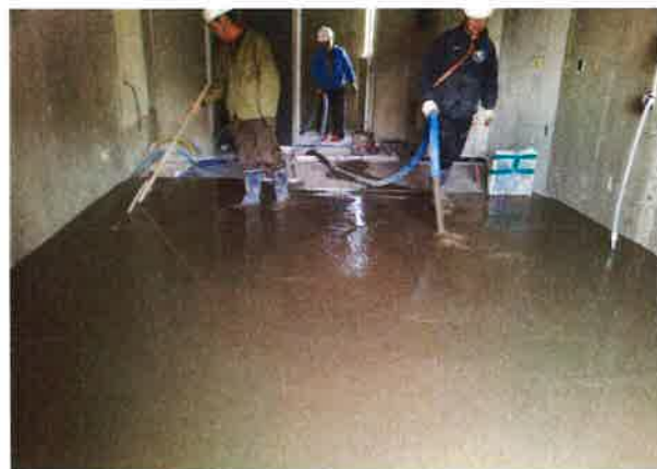
(d) 마감모르터 시공
