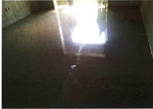
(e) 마감모르터 시공 후
