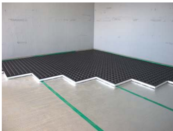
(c) 프리보드 플러스 완충재 시공
