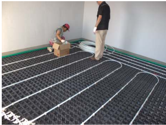
(d) X-L 배관 설치
