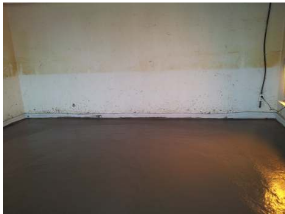
(c) 경량기포콘크리트 타설
