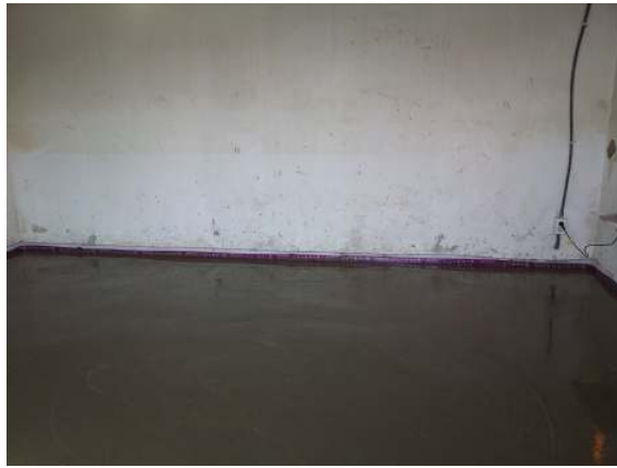
(e) 마감모르터 타설 후
