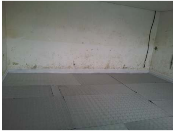
(a) 측면완충재 시공
