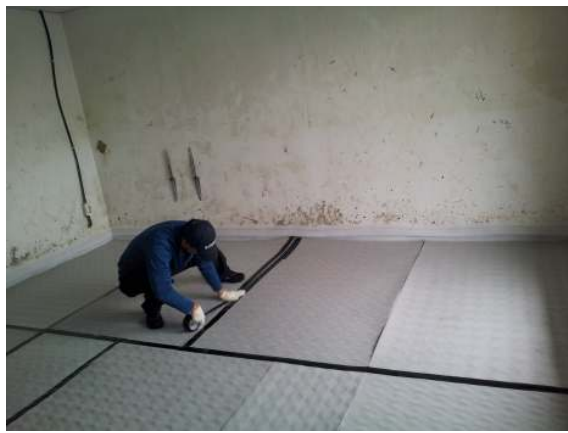
(b) GL차음매트 시공
