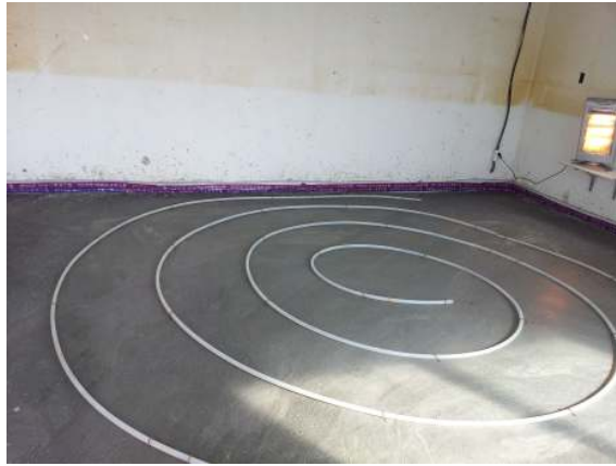
(d) 난방배관 시공 후
