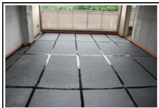
(c) 단열재 시공
