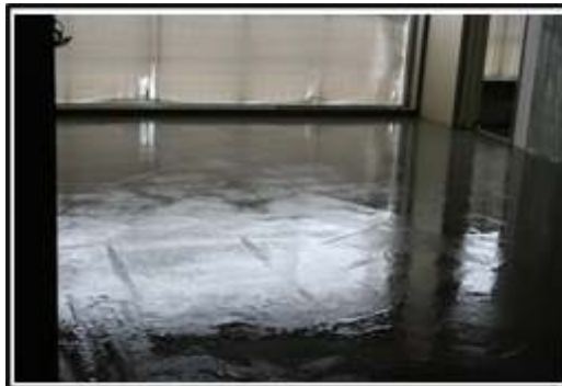
(f) 마감모르터 시공
