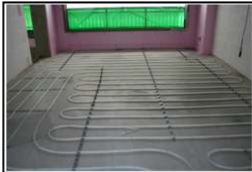
(e) 난방배관 시공
