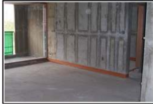
(a) 측면완충재 시공
