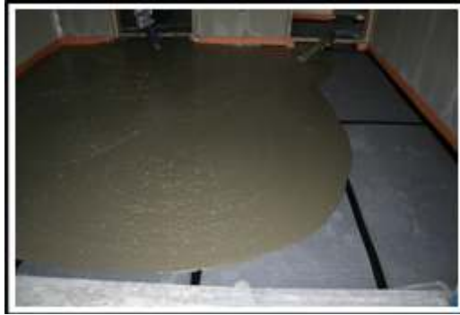
(d) 경량기포 콘크리트 시공
