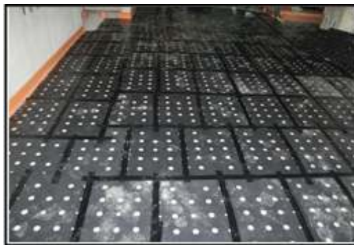
(b) 차음판 (방진재+P.P구조체) 시공
