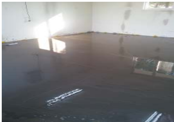
(d) 마감모르터 시공 후
