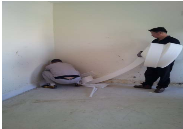
(a) 측면완충재 시공
