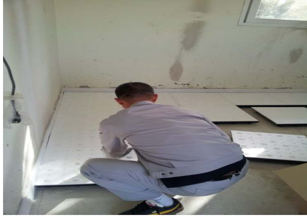
(b) 완충재(미넥스플러스) 시공
