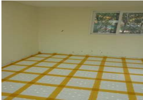
(c) 완충재(미넥스플러스) 시공 후
